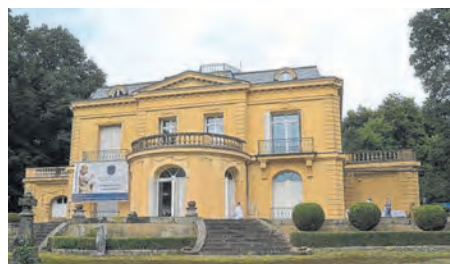
Außenansicht: Bis zum Frühjahr wird die Fassade neu gestrichen. Foto: Theo Körner
