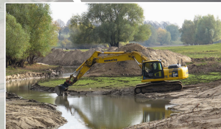
Für die Reaktivierung und Entschlammung der Auengewässer ist der Einsatz von schwerem Gerät notwendig
