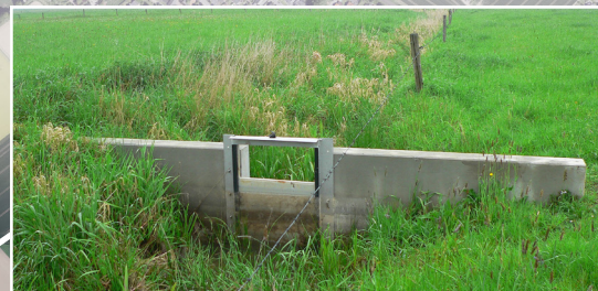
Mit mehreren verstellbaren Stauwehren wird ein Entwässerungsgraben aufgestaut und so wieder mehr Wasser länger in der Fläche gehalten
