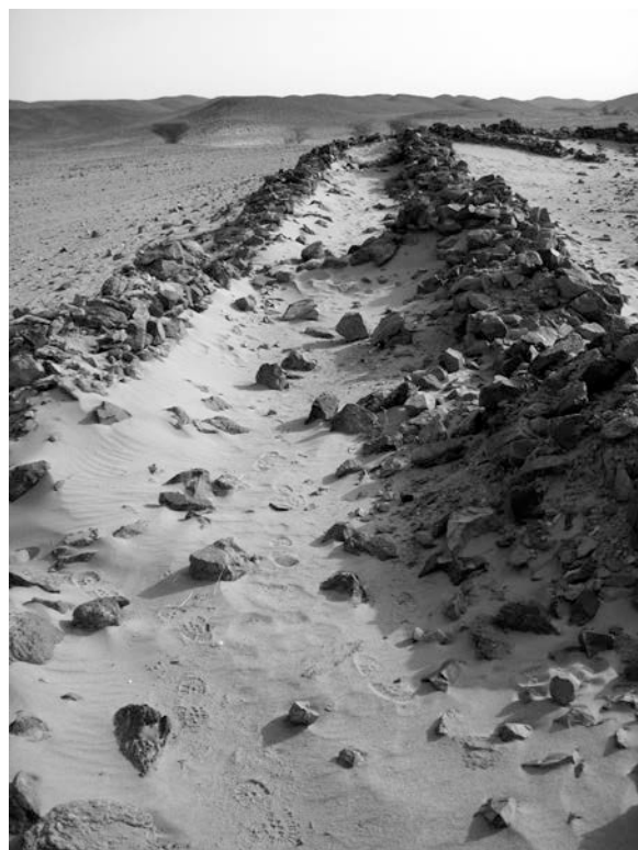
Abb. 8: Heutiger Zustand der langgestreckten Räume in der äußeren Umwallung. Flugsand bedeckt den Mauerwerksversturz und ist gegen die Mauern angebösch (Foto: D. Eigner). Vgl. auch Abb. 3.
