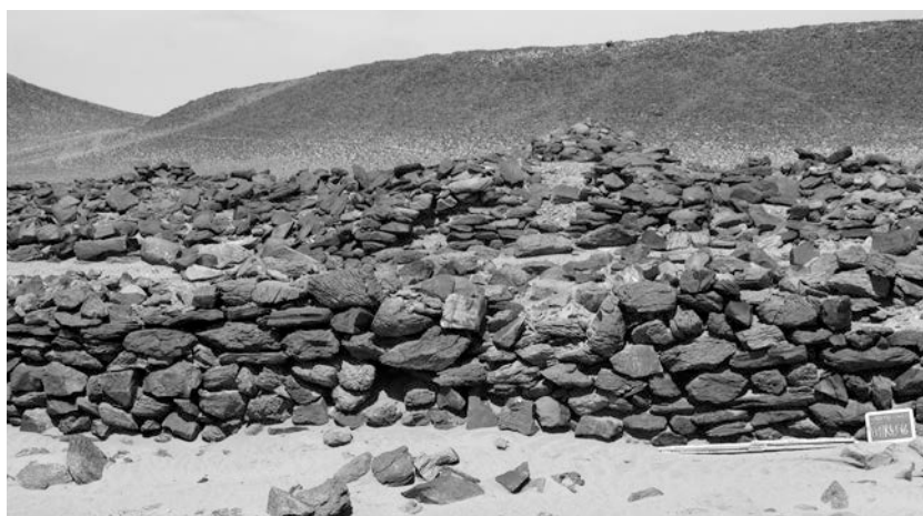
Abb. 6: Für Umm Ruweim 1 typisches Mauerwerk in der Wand zwischen Hof 1 und den Räumen 45 – 46. Roh gebrochene plattige und kubische Bausteine. Die Fugen sind mitunter mit kleineren Steinsplittern verkeilt (Foto: A. Lohwasser).
