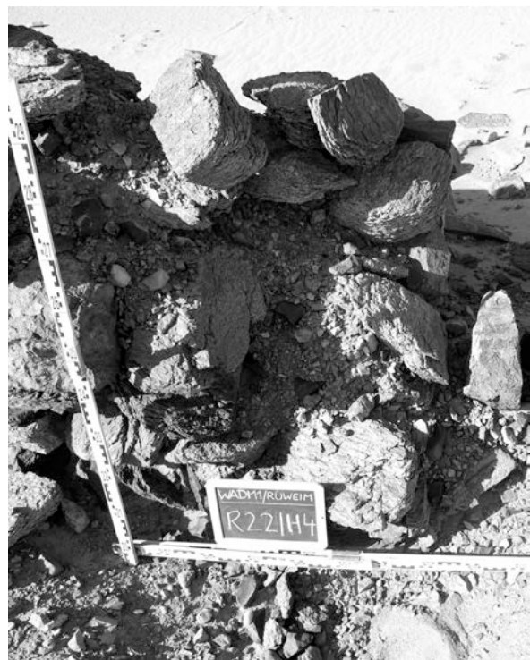
Abb. 7: Detail des Mauerwerks zwischen Raum 22 und Hof 4. Fugen und Hohlräume sind mit Gesteinsgrus und Steinsplittern gefüllt (Foto: A. Lohwasser).
