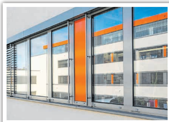
Der PharmaCampus ist das größte Gebäude der WWU. Charakteristisch sind die orangefarbenen Farbakzente an der Fassade.
