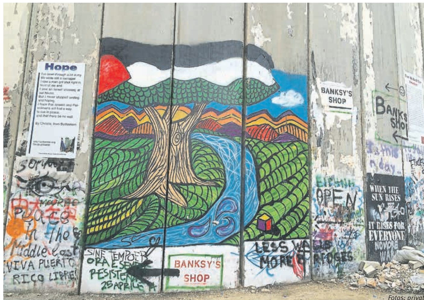
Die Sperranlage entlang der Grenzlinie zwischen Israel und dem Westjordanland besteht in Bethlehem aus einer bis acht Meter hohen Betonmauer.
