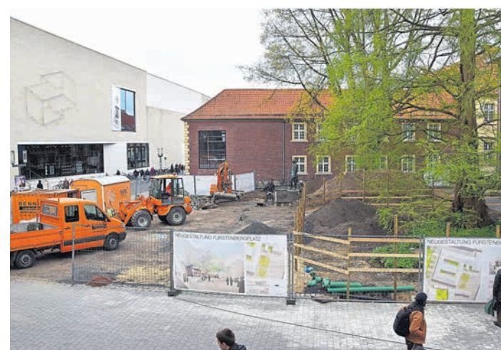
Die Bauarbeiten haben bereits begonnen. Bis Juni soll der Platz vor dem Fürstenberghaus fertiggestellt werden.
