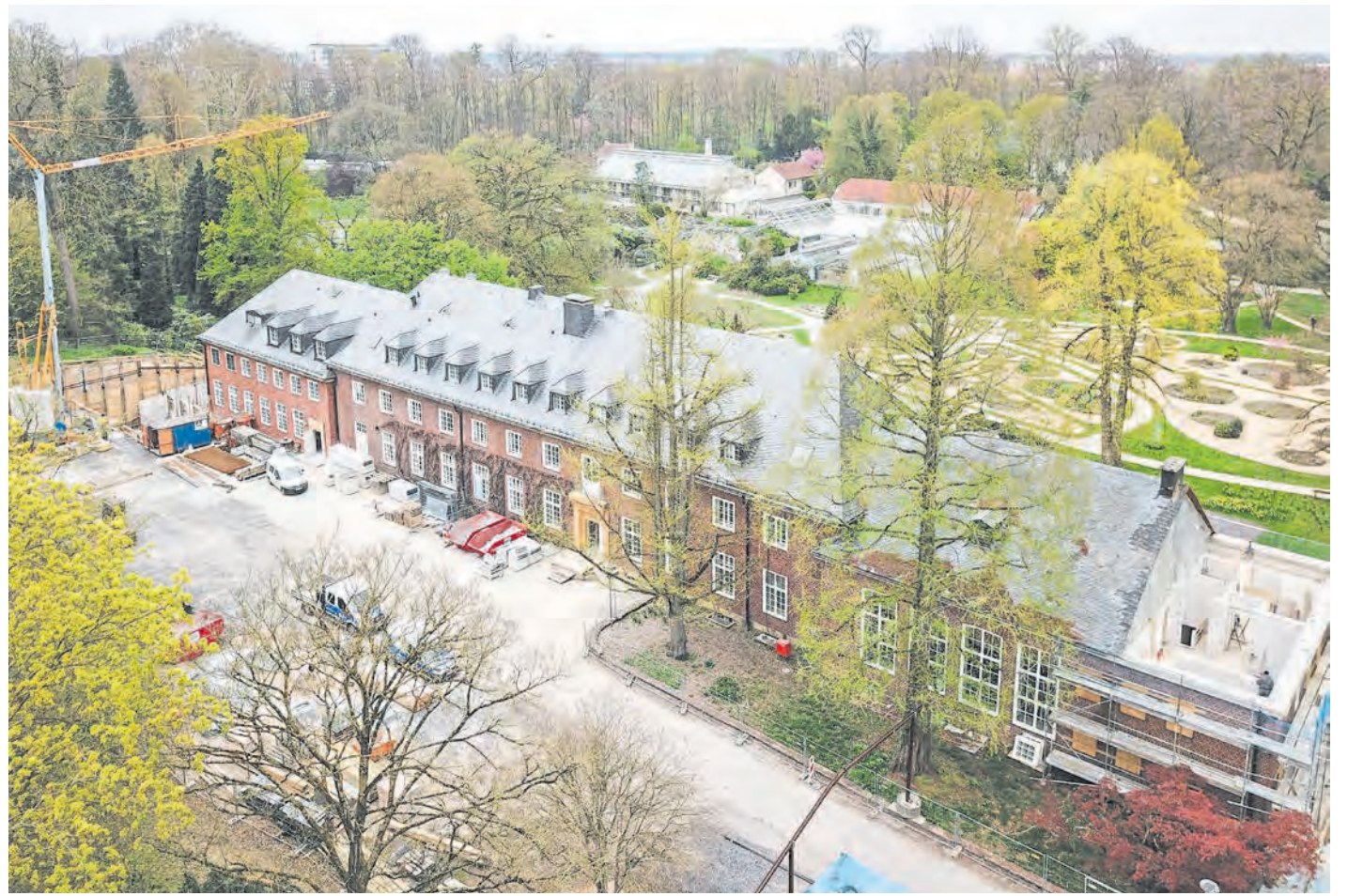
Die Bauarbeiten laufen auf Hochtouren: Auf rund 4.200 Quadratmetern Nutzfläche entsteht im ehemaligen Institut für Botanik an der Südseite des Botanischen Gartens das zukünftige „Haus der Studierendenservices“.
