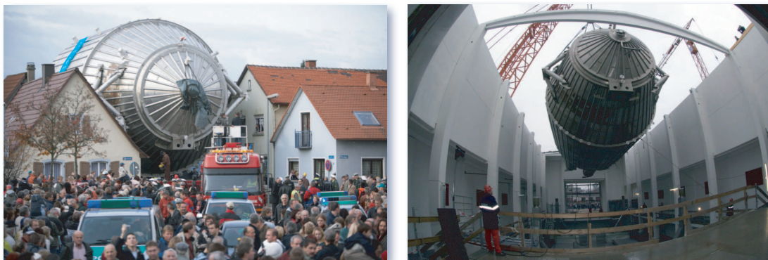
Abbildung 3.3: Bilder der Lieferung des Hauptspektrometers; links: Die enge Passage durch Eggenstein-Leopoldshafen; rechts: Einhub des Spektrometers durch das Dach der KATRIN-Haupthalle. Quelle der Bilder: Forschungszentrum Karlsruhe.
